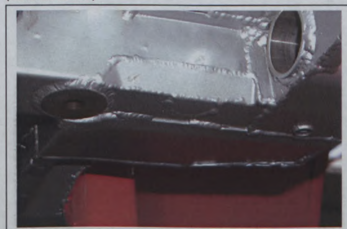
7/ Détail de la zone modifiée de la traverse arrière ( Idem 09/02 WR )
