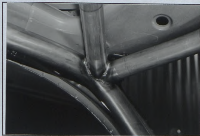
PHOTO N° 03 arceau avant supérieur gauche
