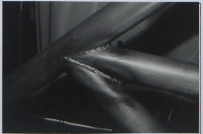
PHOTO N° 09 noeud arriere longitudinal gauche
