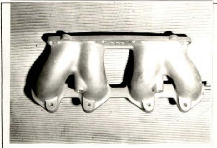
I) Collecteur d'admission Inlet manifold
