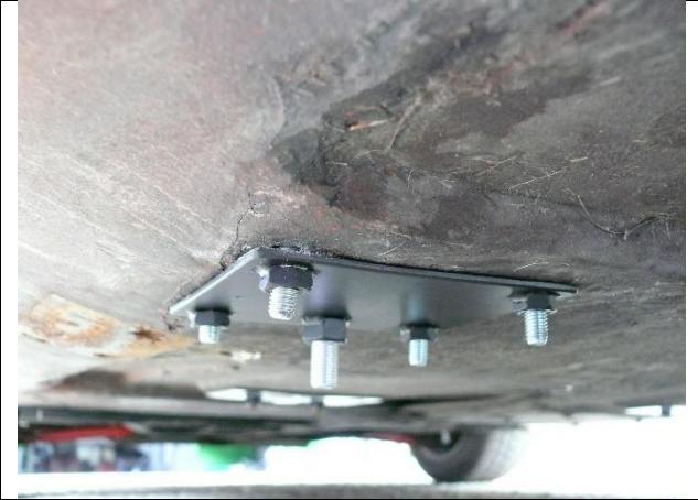
PHOTO 18 Contre-plaque sous châssis arceau principal.
